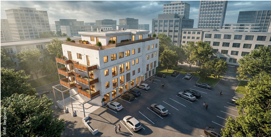
Das „Gelbe Haus“ in Mosbach war für Bergmann und Badia der Praxistest, um zu zeigen, wie Digitalisierung im Bestand funktioniert. Bergmann hat dort die komplette TGA für 16 Einheiten saniert, inklusive Wärmepumpentechnik und Fußbodenheizungen.
