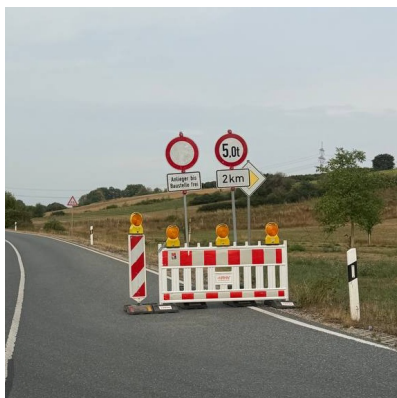
Bild 7: Noch einmal „Anlieger bis Baustelle frei“. Für Ihren Besuch bei myFischer weiterfahren; der eigentliche gesperrte Baustellenabschnitt liegt hinter Vincenzenbronn Richtung Großhabersdorf.
